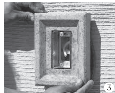
Centrez la pierre de la boîte électrique sur la boîte d'extension; à niveau et d'aplomb. Utilisez des cales amovibles si nécessaire.
