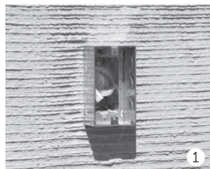
Fixez le boîtier d'extension homologué UL à la boîte électrique précâblée et montée.
