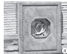
Terminez la pose du placage en pierre fabriqué ou de tout autre matériau extérieur autour de la pierre de la boîte électrique.
