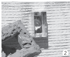
Appliquez le mortier au dos de la pierre de la boîte électrique ou du substrat préparé.
